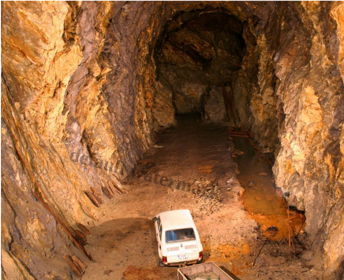
Hoge ondergrondse tunnel in Complex Rzeczká
